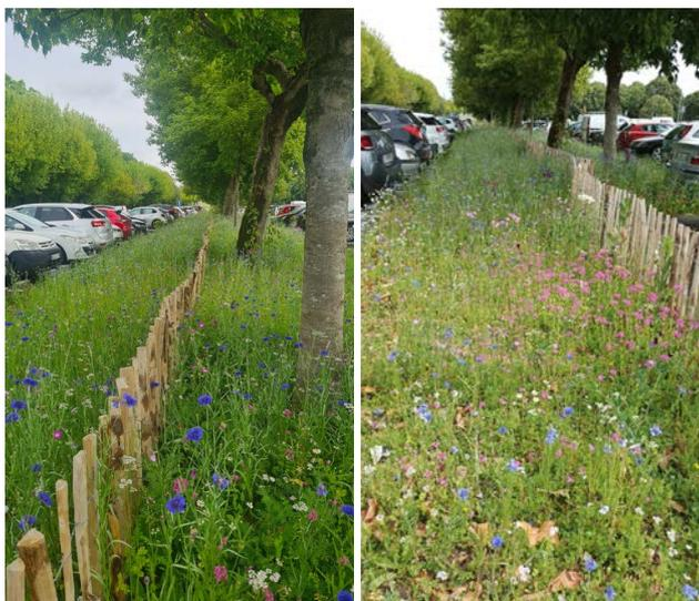
Rochefort : reconfiguration du parking Roy Bry. Désimperméabilisation, infiltration des eaux de ruissellement et végétalisation.
