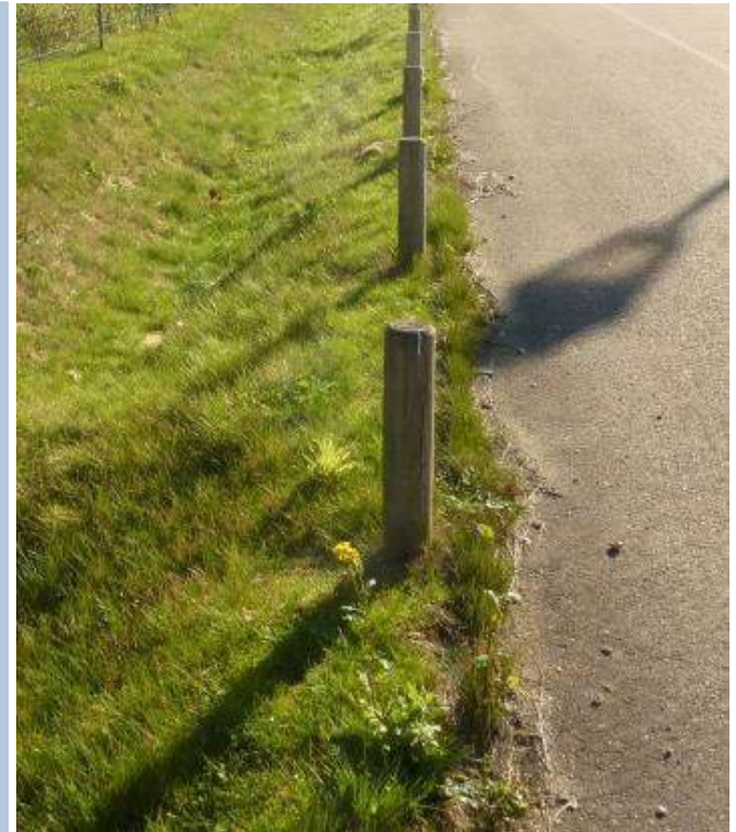
Dispositif de protection d'une noue à installer dès la phase chantier (avec l'autorisation de AREA).
