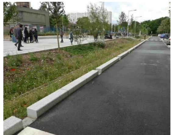
La Courneuve : Noue végétalisée avec ruissellement direct (avec l'autorisation de l'APUR)
