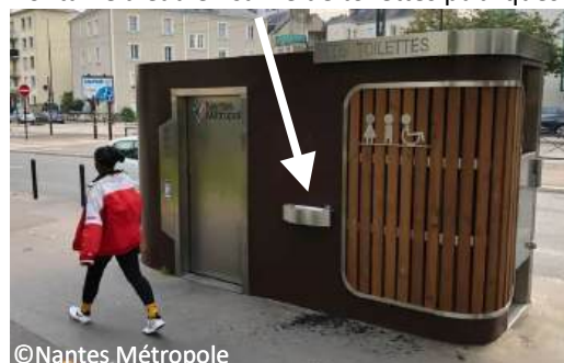
Fontaine à eau en saillie de toilettes publiques
