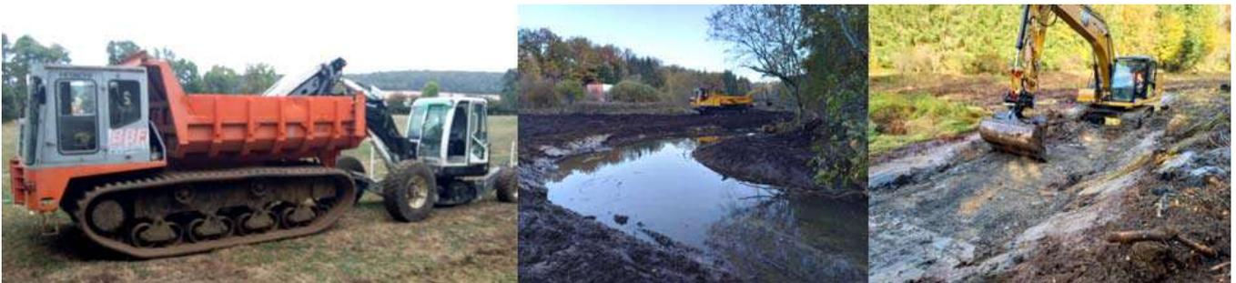
Divers engins de chantier dont, à gauche, dumper à chenilles spécialisé dans la réalisation de travaux en milieux humides (EPAGE Sequana)
