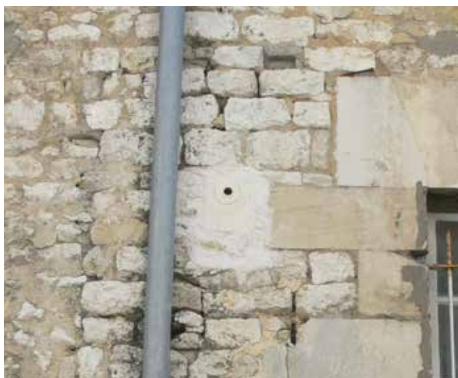
Nichoirs à intégrer dans un mur maçonné. 1. Pour moineaux 2. Pour espèces cavicoles
