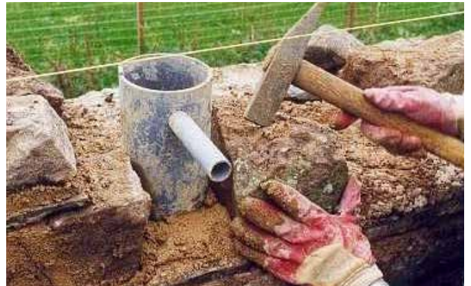
Intégration d'un nichoir dans un mur de moellons
