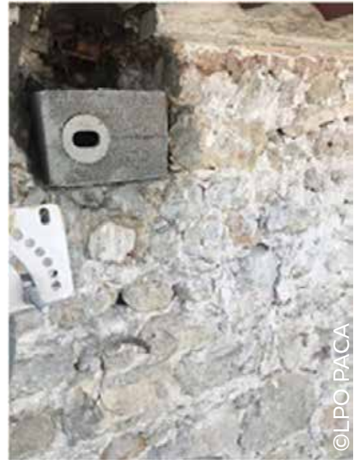
Intégration de nichoirs Schwegler n° 25 par l'entreprise TC BAT AZUR Katherine Dubourg, LPO PACA
