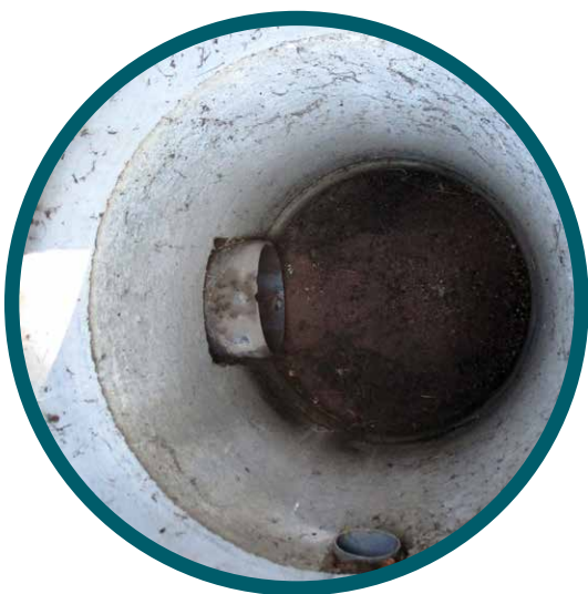
Puits d'infiltration rue de la Rive • Saint-Cyprien
