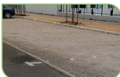
Dalles alvéolaires avec gravillonnage sur parking rue Massenet • Bonson
