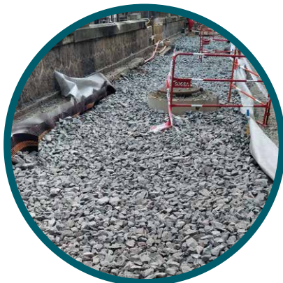
Structure stockante quai d'Astrée • Montbrison
