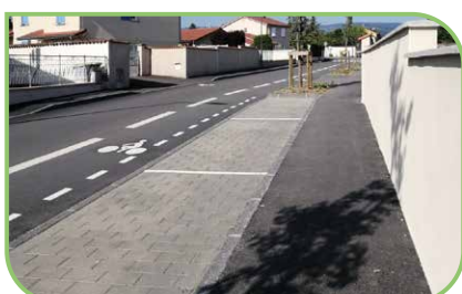
Parking en pavés perméables rue Chantelauze • Montbrison
