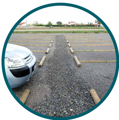
Tranchée d'infiltration sur l'aire de covoiturage Saint-Côme • Saint-Just Saint-Rambert
