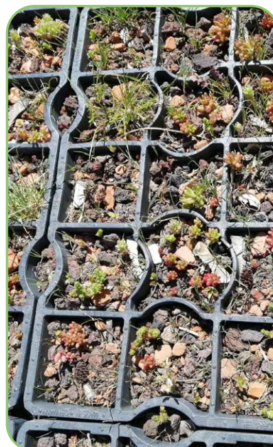
Dalles alvéolaires mousses, aire de covoiturage • Montbrison
