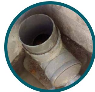
Ajutage circulaire aire de covoiturage • Montbrison
