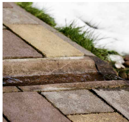
La rigole maçonnée en galets, pavés et/ou béton
