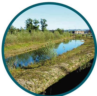
Bassin en eau ZAC des Plaines • Bonson et Sury-le-Comtal
