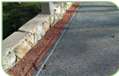
Béton poreux sur les trottoirs rue du Midi • Craitilleux
