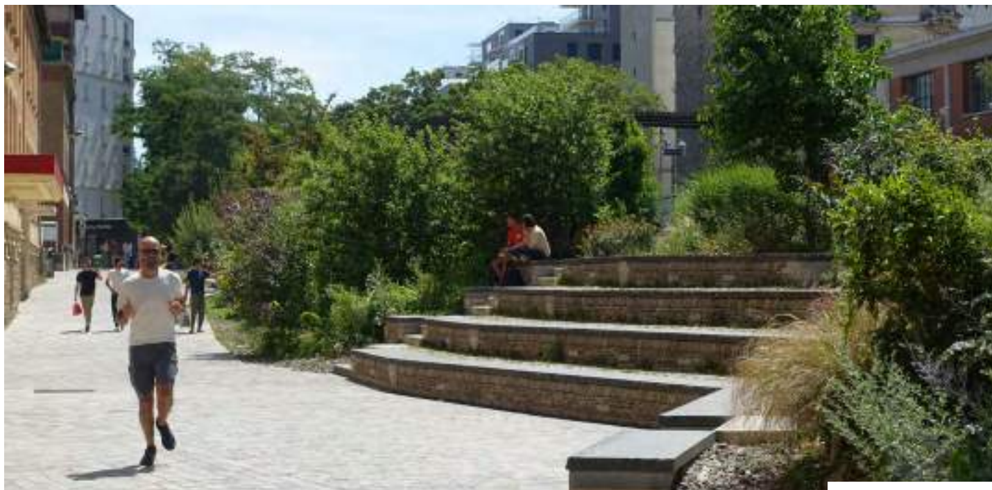
Pour la réalisation de la Promenade Nardal à Paris (75), les matériaux des revêtements de sols et des murets de pierres sèches sont des pierres naturelles de réemploi issues du centre de stockage de matériaux de la ville de Paris. Conception: Atelier Nous © Sandrine Larramendy, P&C
