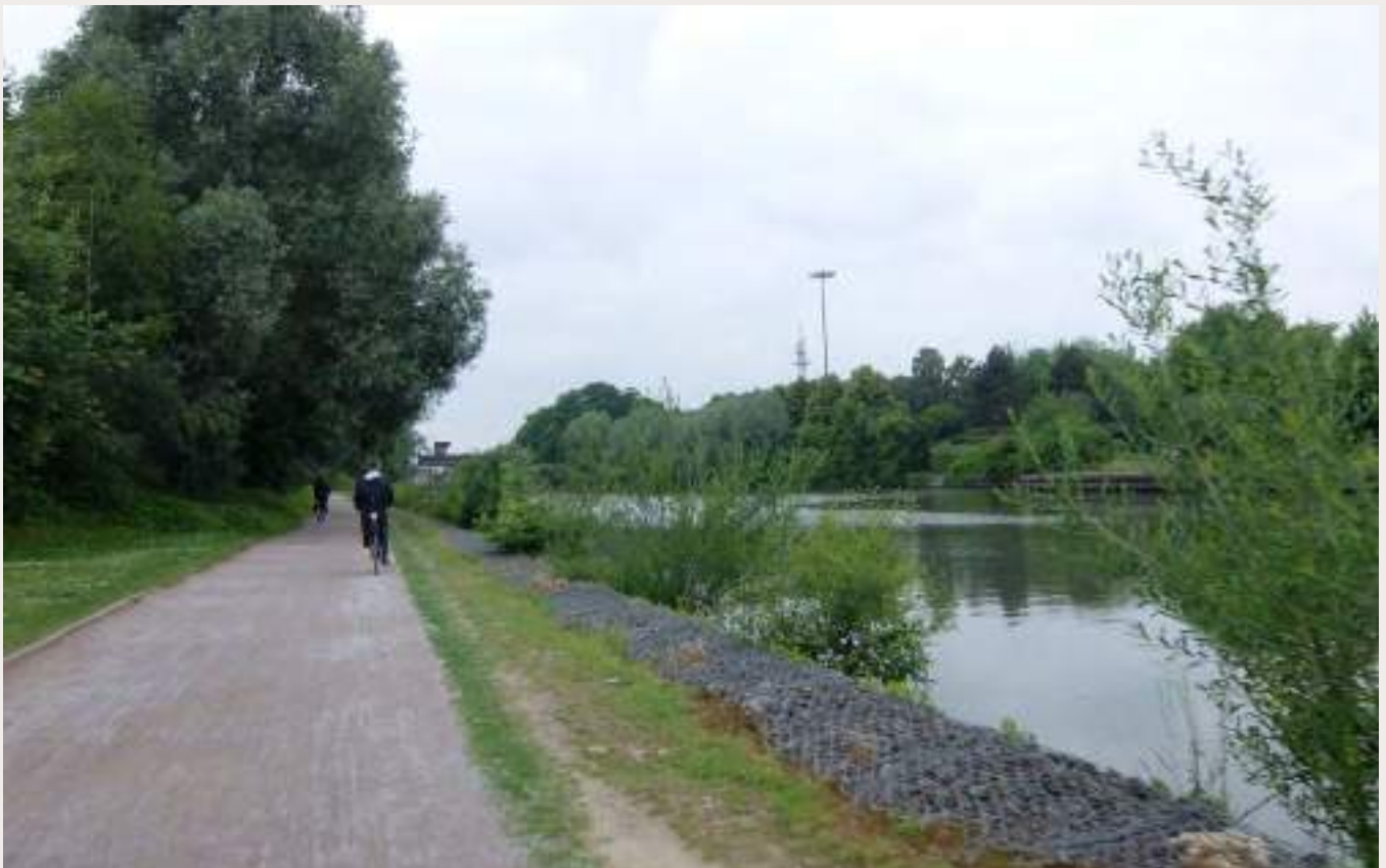
Berges de la Deûle après restauration, Lille (59). © Sandrine Larramendy, P&C
