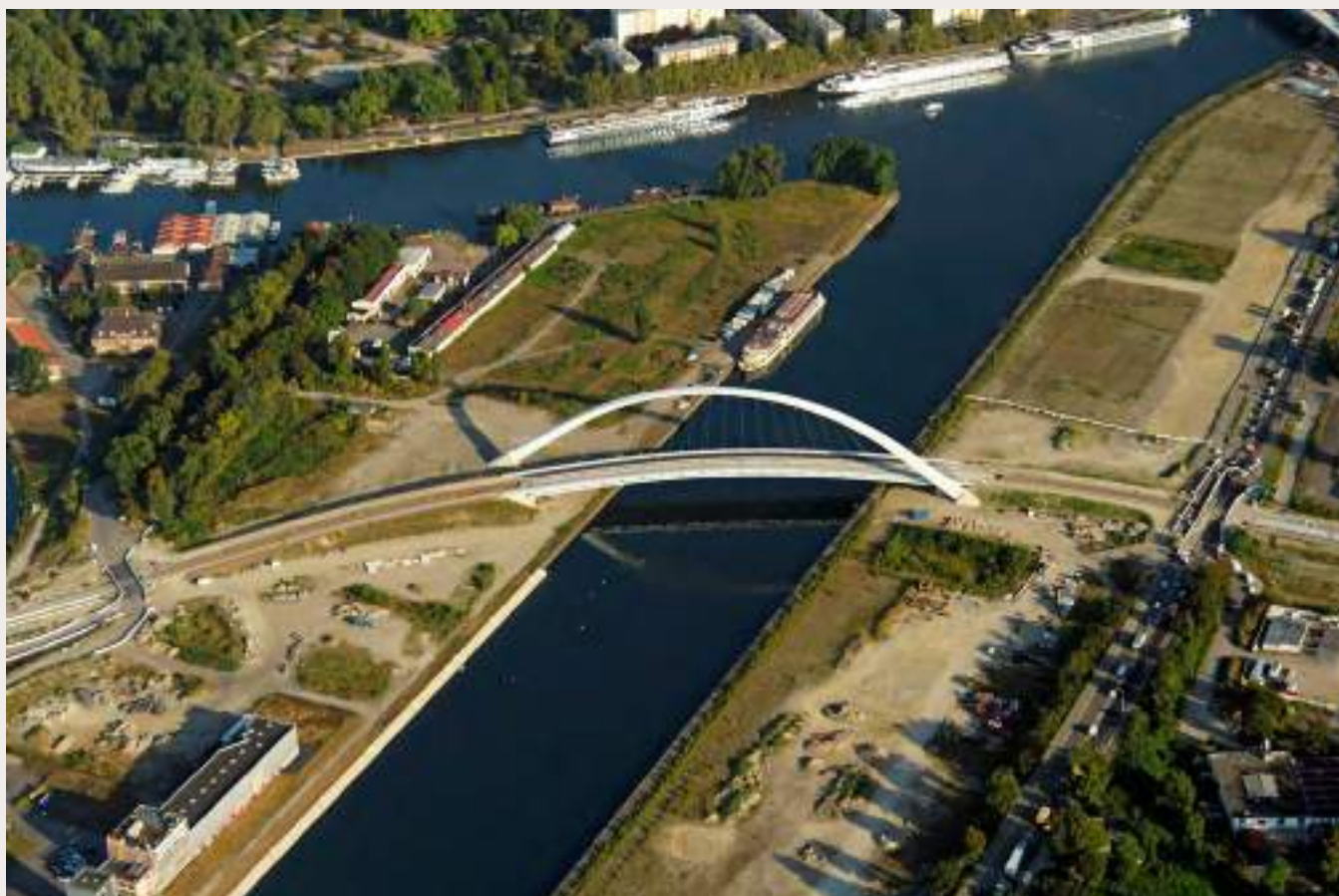
Les plateformes sont installées au nord des quartiers Citadelle (à gauche) et Starlette (à droite), de part et d'autre du bassin Vauban.
