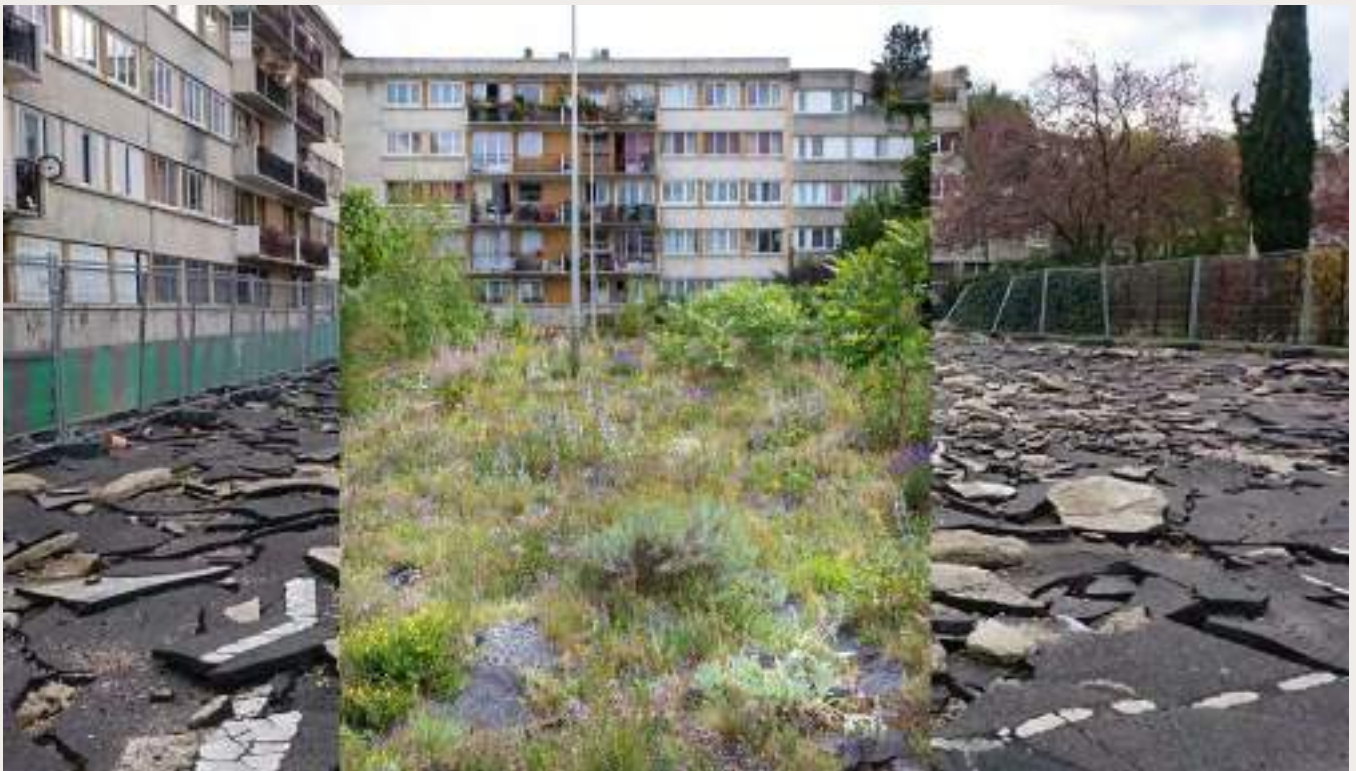
Pendant les travaux de découpe de l'enrobé et de décompactage puis, au centre, après plantation. Jardin joyeux, Aubervilliers (93)
