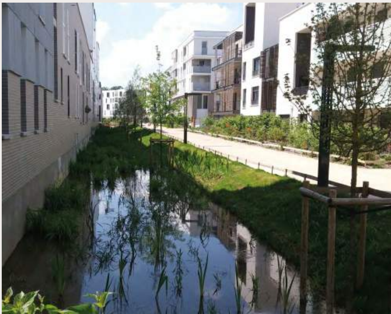
Noues après fortes pluies, écoquartier Camille Claudel, Palaiseau (91).
