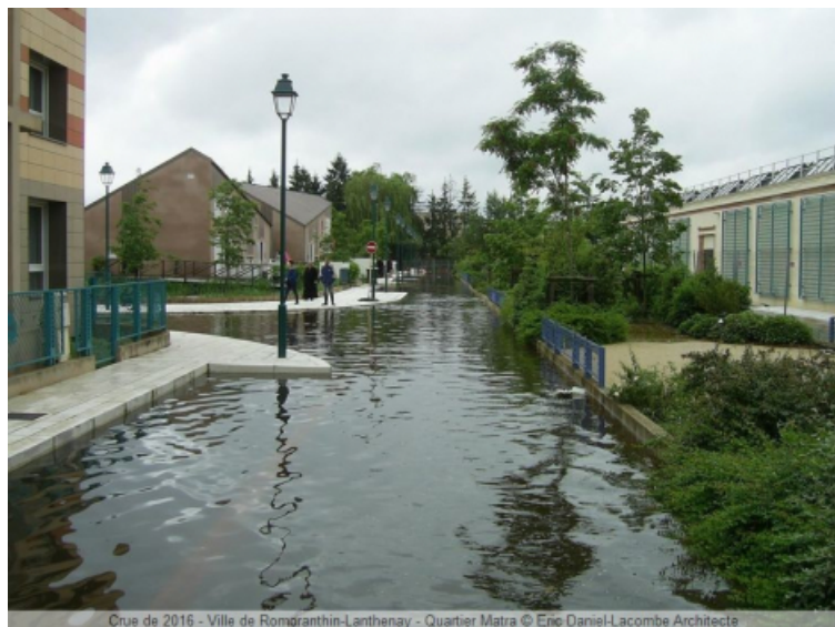
Crue de 2016 - Ville de Romorantin-Lanthenay - Quartier Matra © Eric Daniel-Lacombe Architecte
