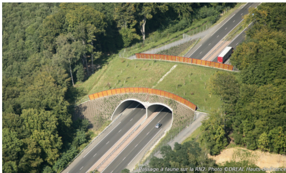
Passage à faune sur la RN2. Photo ©DREAL Hauts-de-France
